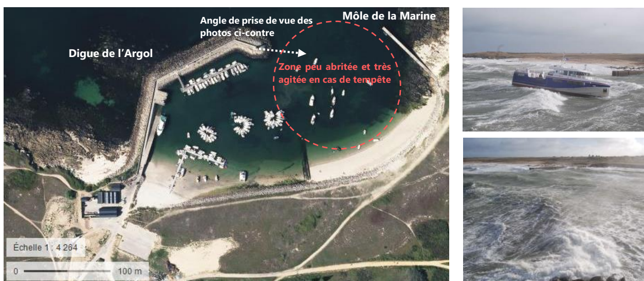
FIGURE 3 : VUE AERIENNE DU PORT DE L'ARGOL ET PROBLEMATIQUE
