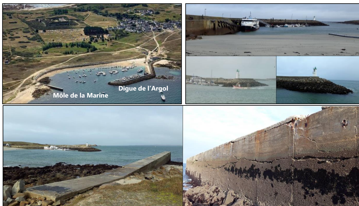
FIGURE 2 - PORT DE L'ARGOL (EN HAUT A GAUCHE), DIGUE OUEST ET PONTON FLOTTANT (EN HAUT A DROITE) ET MOLE DE LA MARINE (EN BAS)
