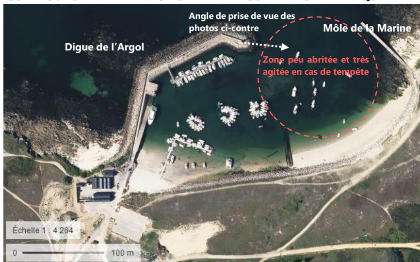
FIGURE 18 : VUE AERIENNE DU PORT DE L'ARGOL ET PROBLEMATIQUE
